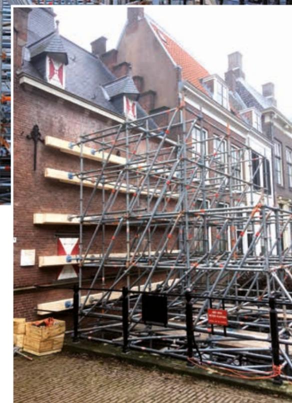
Pendant la durée du projet, la totalité du mur de la Koetshuis et du jardin est contrôlée et surveillée à l'aide entre autres d'un théodolite. Des miroirs sont placés sur les murs afin de constater tout nouvel écart ou affaissement. Pour ces mêmes raisons, la construction d'échafaudages sera également munie des miroirs nécessaires. Une bonne collaboration avec Layher Engineering conduit à de beaux projets. Broeke Steigerbouw est prêt pour l'avenir.
