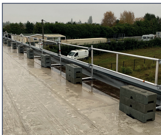
La protection pour rive de toiture compacte entièrement assemblée avec des garde-corps d'échafaudage roulants.
