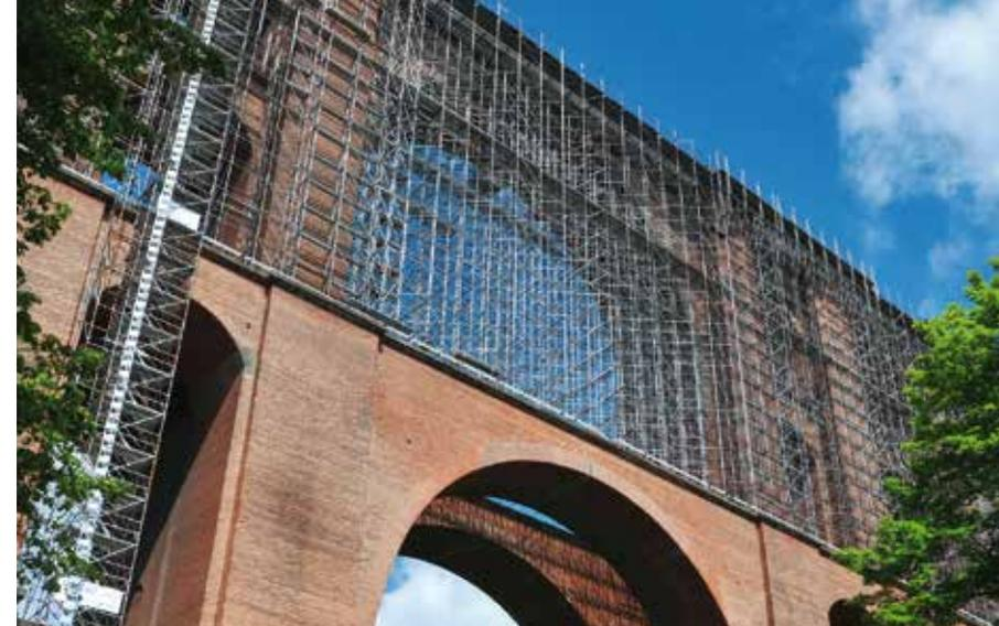
En cas de travaux d'entretien sur un bâtiment existant, l'échafaudage de façade Allround pour la rénovation suffit. Il s'agit d'un modèle étroit (0,73m), particulièrement adapté au centre des villes et aux endroits exigus.
