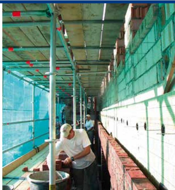
L'ouverture entre l'échafaudage et le gros œuvre est sécurisée à l'aide de plancher posé sur des poutres escamotables (ou des consoles escamotables, 0,4 – 0,6m).
