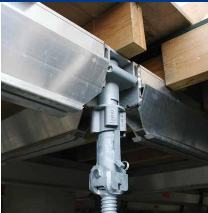
L'utilisation d'un étaielement Allround offre une stabilité et une sécurité accrues par rapport aux étais non fixés. Un grand arsenal de composantes spéciales est mis à disposition pour la réalisation des étaielements. Le système est aussi applicable pour les étaielements plus lourds requis dans le cadre de la construction de routes et d'ouvrages hydrauliques. Layher propose également des tours à monter manuellement dont la capacité de charge atteint jusqu'à 90 tonnes.
