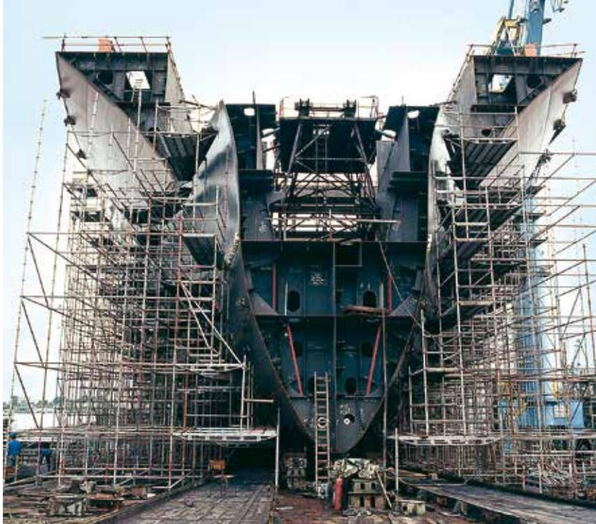
En Belgique et au Pays-Bas, les échafaudages Layher Allround sont utilisés à grande échelle dans l'industrie (pétrochimique) et la construction navale. Toutes les installations d'usines chimiques en extérieur requièrent un entretien constant, et ce afin de garantir la continuité de la production mais aussi d'éviter tout risque d'explosion et d'incendie.
