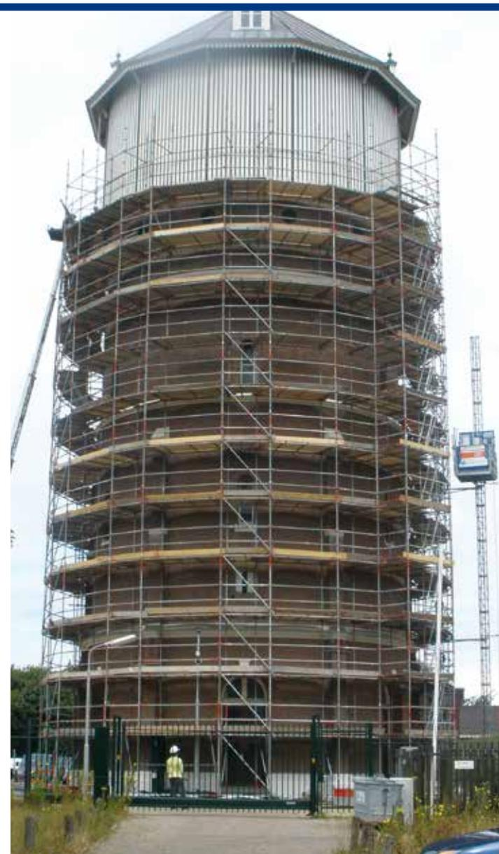
Par rénovation, nous pensons entre autres à la réparation de la maçonnerie, au changement de châssis, au revêtement des façades et à la peinture. Étant donné la nature des activités, il n'est pas nécessaire de placer de grandes quantités de matériaux sur les planchers. Au besoin, cet échafaudage étroit peut être élargi à l'aide de consoles.
