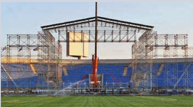
Construction d'une partie du toit d'une scène de concert.
