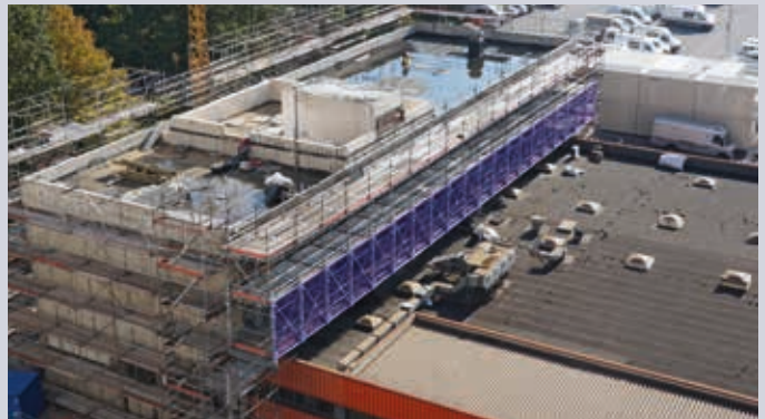
42 m construction système de pontage Allround avec un support central.
