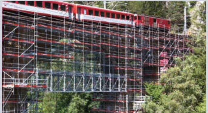
Soutien des système de pontage Allround sous un pont.
