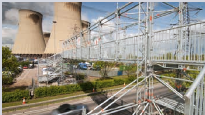
Système du pontage Allround de Layher passerelle entre le parking et le lieu de travail.
