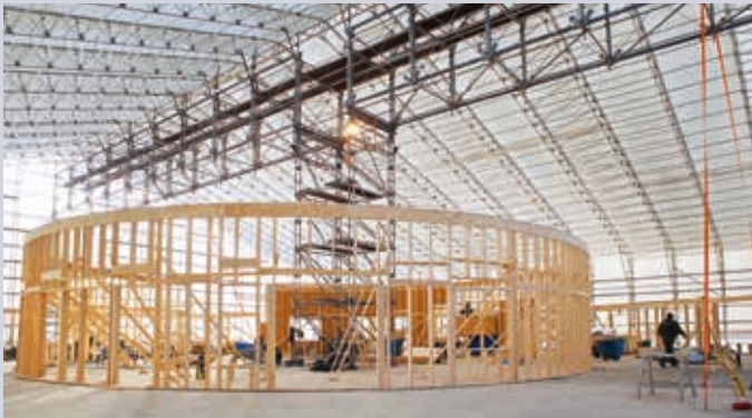
Support de poutre de faîte pour Layher-bâche couvrable XL avec une envergure énorme.
