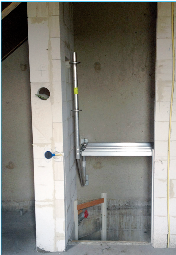
Trapgatconsole in gesloten trapgat
