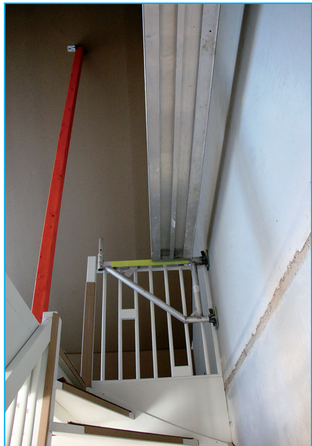
Trapgatconsole tijdens opbouw in open trapgat
