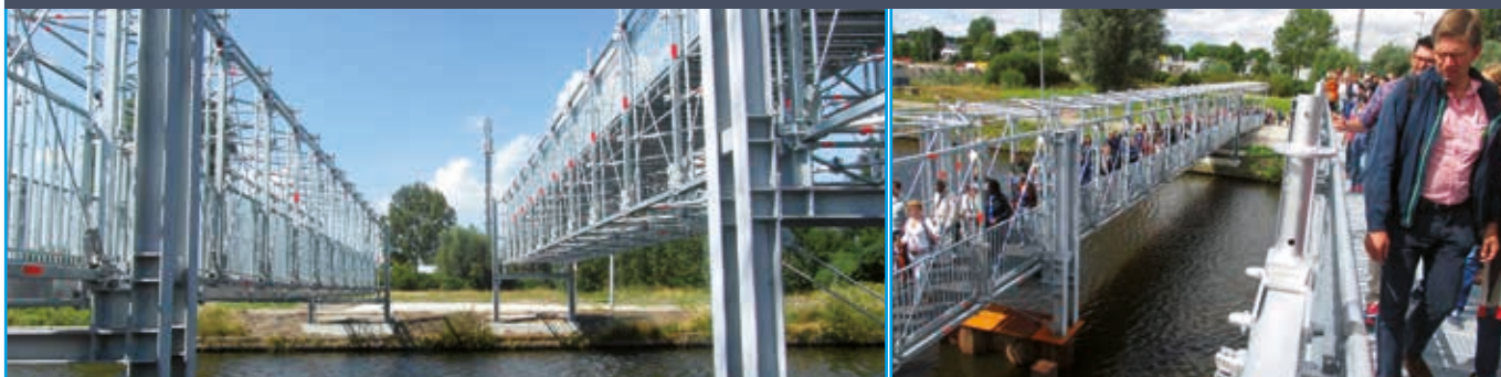
Het Allround Brugsysteem als fiets- en voetgangersbrug.
