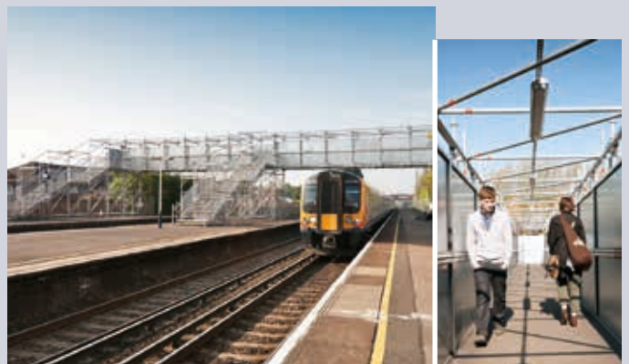
Loopbrug met protect gevelbekleding aan de binnenkant ter bescherming van voetgangers.
