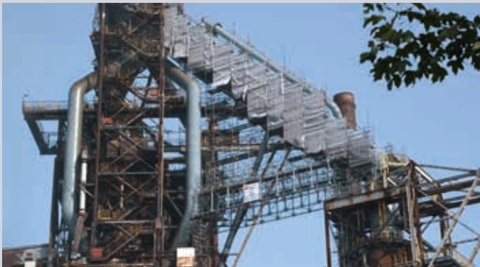
„Vliegende” constructie als ondersteuning van industrie-steigerconstructie.
