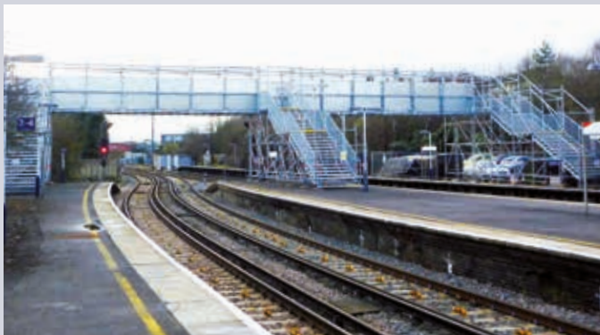
Afgeschermd voetgangersbrug spoorstation.
