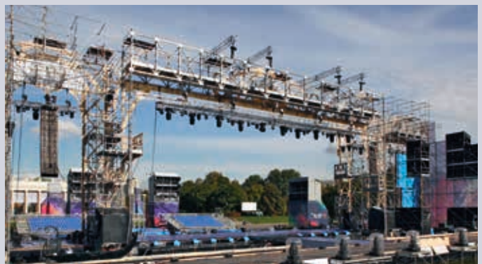
Bevestiging van de „productie” (licht&geluid) op een concertpodium.
